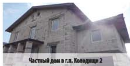
Частный дом в г.п. Колодищи 2 (полигон)
